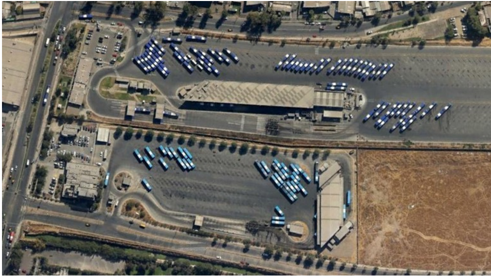
Fotografía 22: Terminal Transantiago sector oriente, Av. Recoleta.
