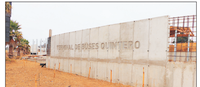
El terminal de Quintero lleva casi la mitad del proyecto de construcción.
