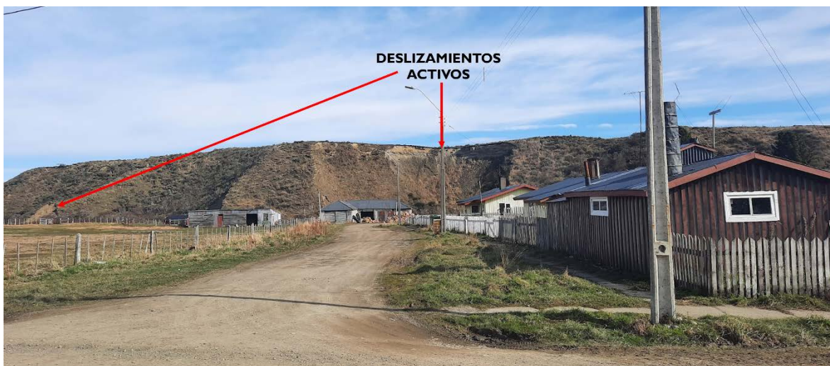
Figura 26 Deslizamiento ladera poniente Villa Cameron
