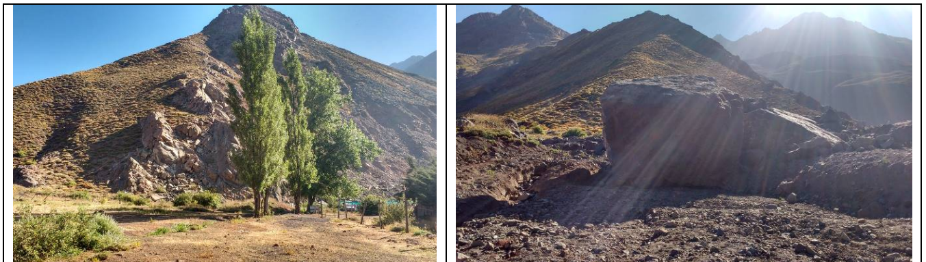
Figura n° 23: Evidencias de caídas de rocas Localidad Termas del Flaco
