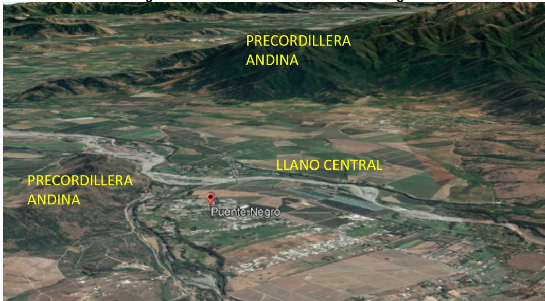
Figura n° 5: Vista de contexto Puente Negro
