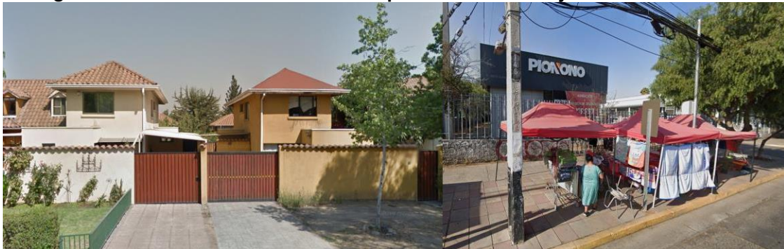
Figura N°30: Edificaciones de uno a dos pisos de altura. Conjunto El Faro de Peñalolén
