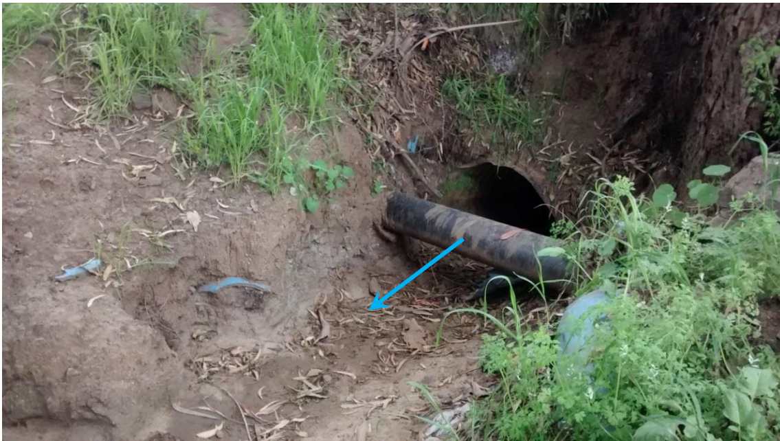
Ilustración 8.4-30 Quebrada N°2 en Punto 10 (4)
