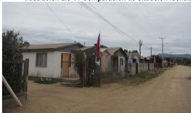
Situación fachadas (3 oriente)
