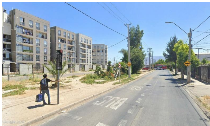
Ilustración 45. Parada PJ1986 en Rodoviario.
