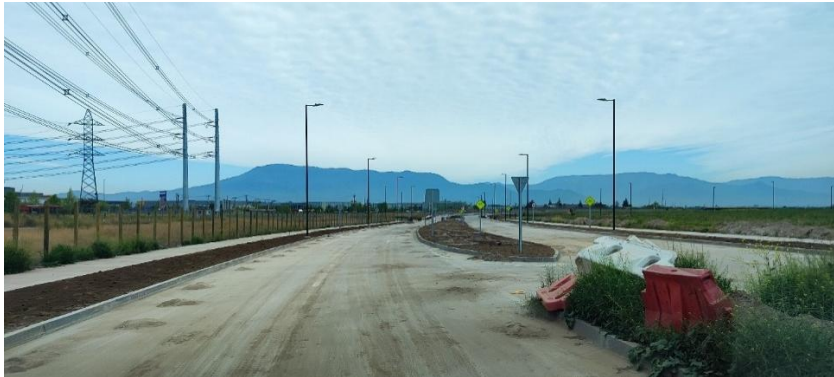
Ilustración 38. Vista de la vía Las Industrias.
