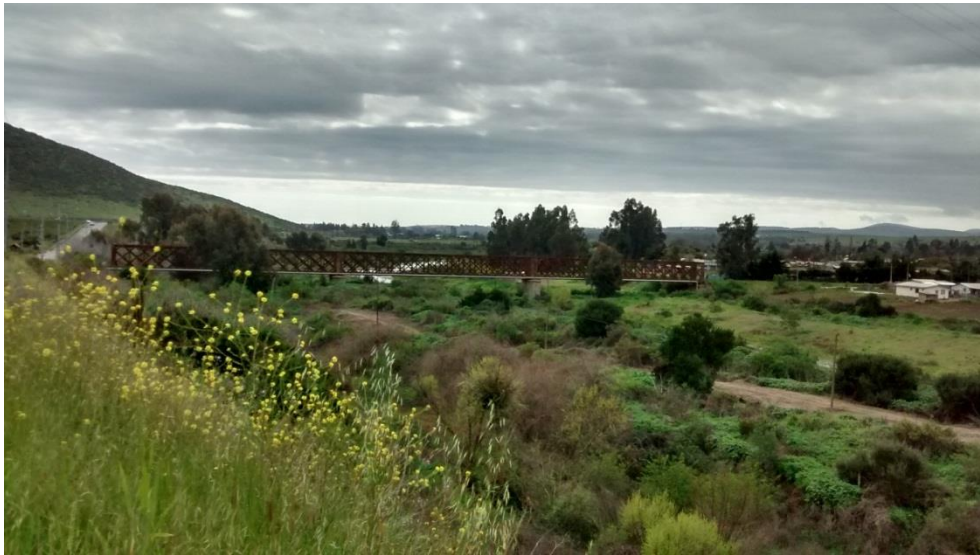
Ilustración 8.5-2: Vistas sector río La Ligua sector aguas arriba del Puente FFCC
