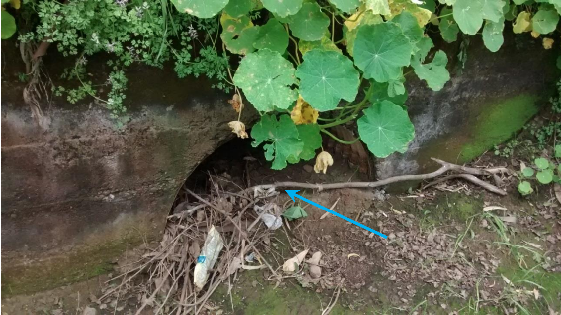
Ilustración 8.4-29 Quebrada N°2 en Punto 10 (3)
