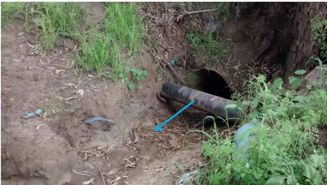
Ilustración 8.4-30 Quebrada N°2 en Punto 10 (4)
