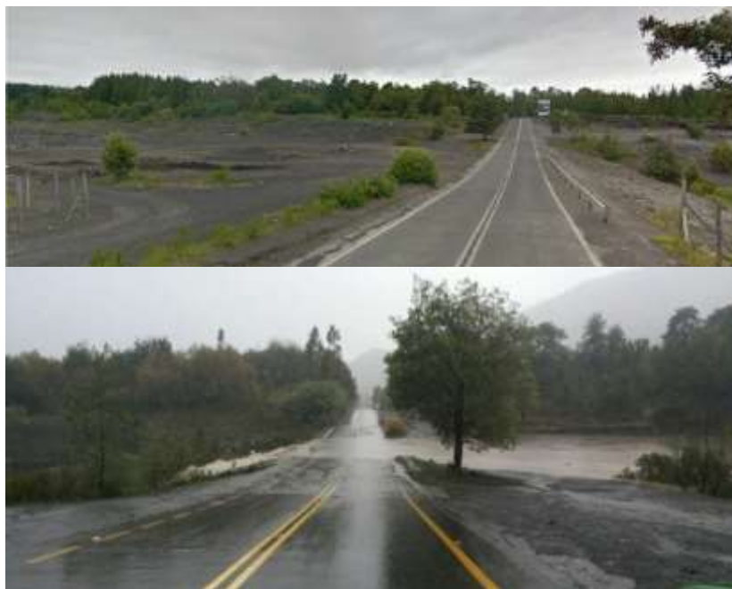
Figura 37. Vistas Área Badén Sector Challupén Seco e Inundado
