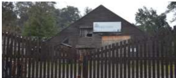
Figura 60 Instalaciones industria maderera
