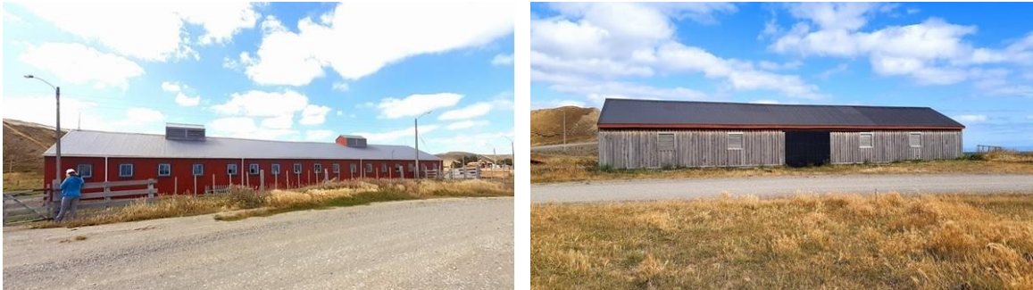
Figura 16. Edificaciones de carácter productivo
