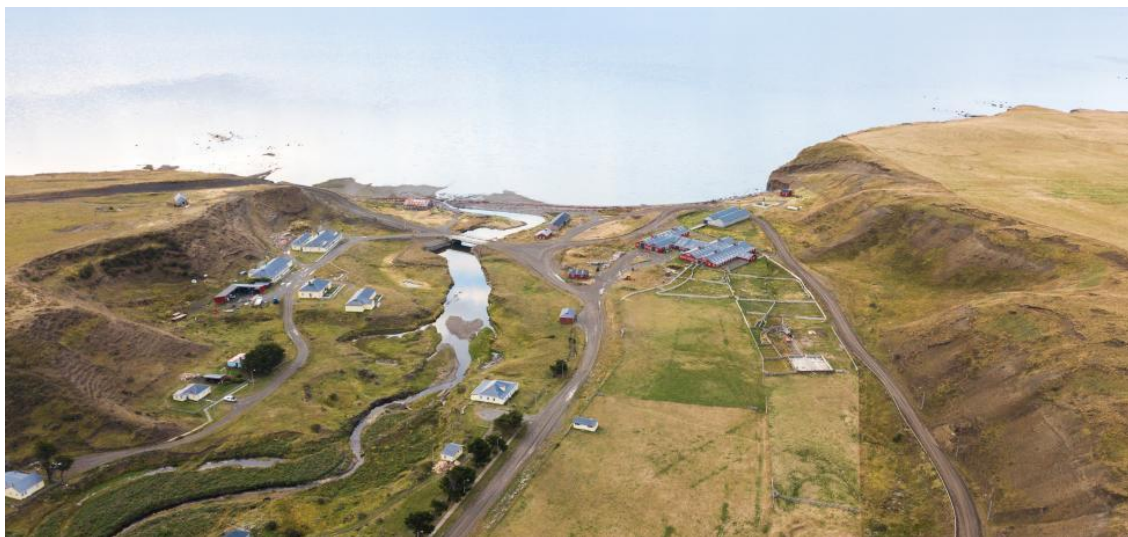
Figura 18. Instalaciones de la Estancia Cameron, en la desembocadura del río Mc. Clelland
