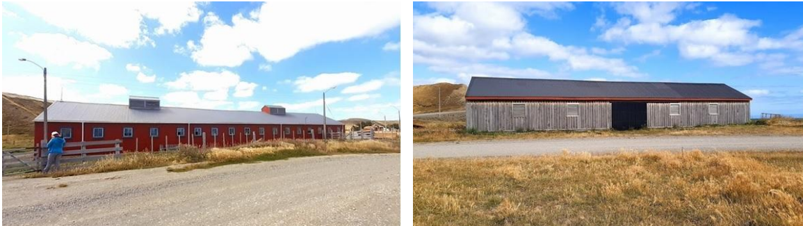
Figura 16. Edificaciones de carácter productivo
