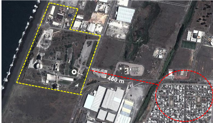
Ilustración 2-23: Planta de Tratamiento de Aguas Servidas, comuna Coronel
