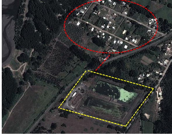
Ilustración 2-25: Planta de Tratamiento de Aguas Servidas, comuna de Hualqui
