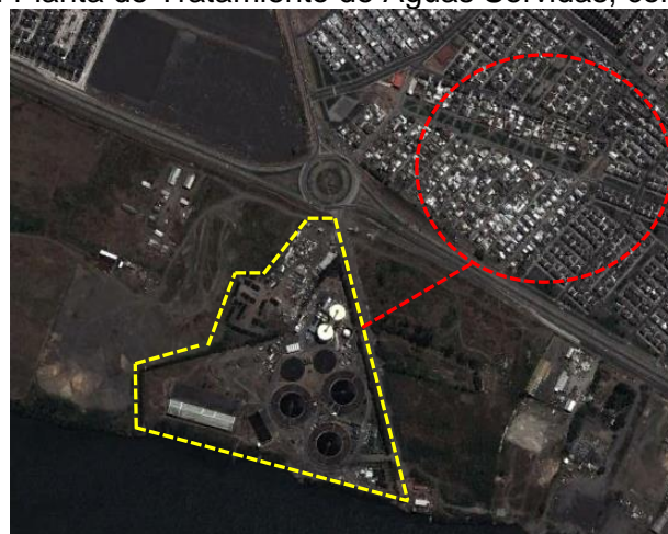
Ilustración 2-24: Planta de Tratamiento de Aguas Servidas, comuna de Hualpén
