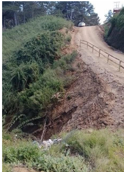
Foto 4 y 5: Deslizamiento de tierra tipo socavón por colapso de cabecera de una cárcava en Quebrada La Granja junto a camino público.
