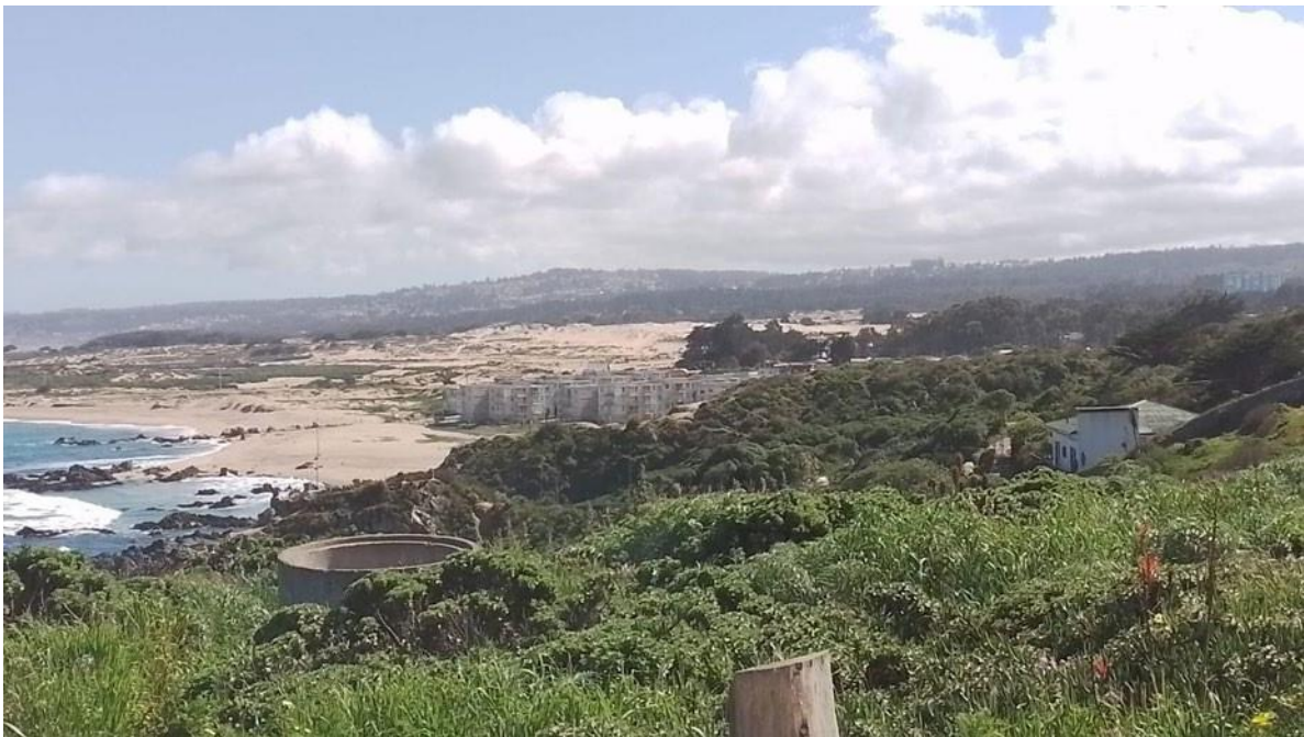
Foto 9: Condominio emplazado sobre zona de inundación por tsunami y zona de inundación por desborde de cauces en desembocadura Quebrada El Canelo. Foto tomada desde Punta del Lacho.
