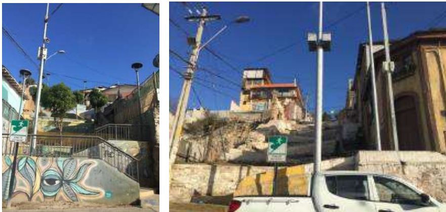
Figura 3-17 Zigzag calles Bilbao, Garriga. Fuente: Elaboración propia.
