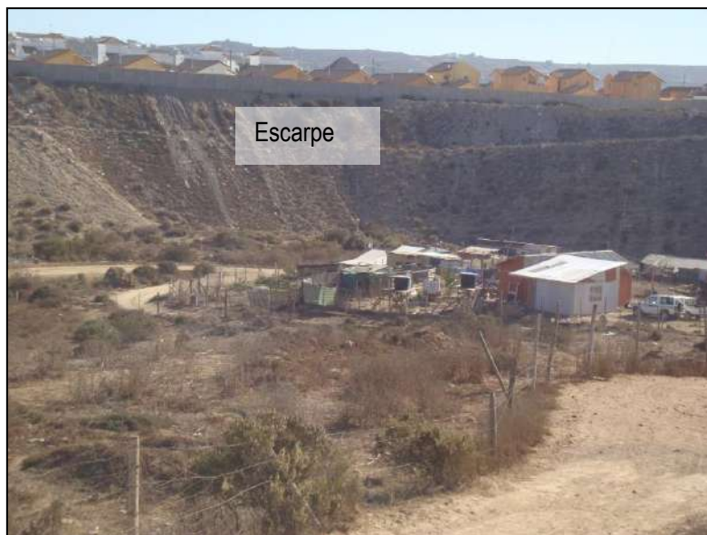
Figura 7-68 Escarpe de la quebrada Las Rosas. Fuente: (Ilustre Municipalidad de Coquimbo, 2019)
