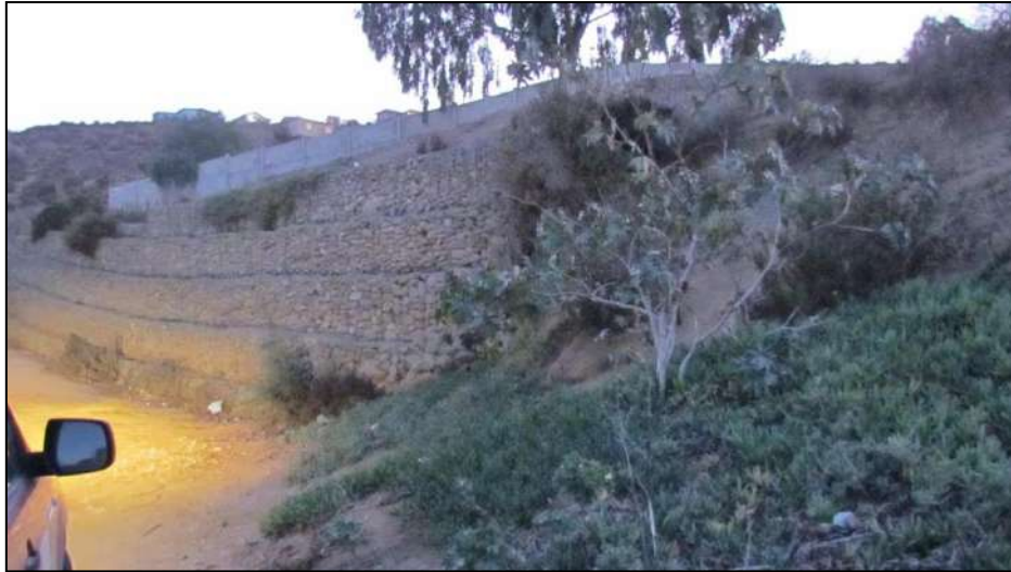
Figura 7-69 Muro de contención para flujos de barro en Guanqueros
