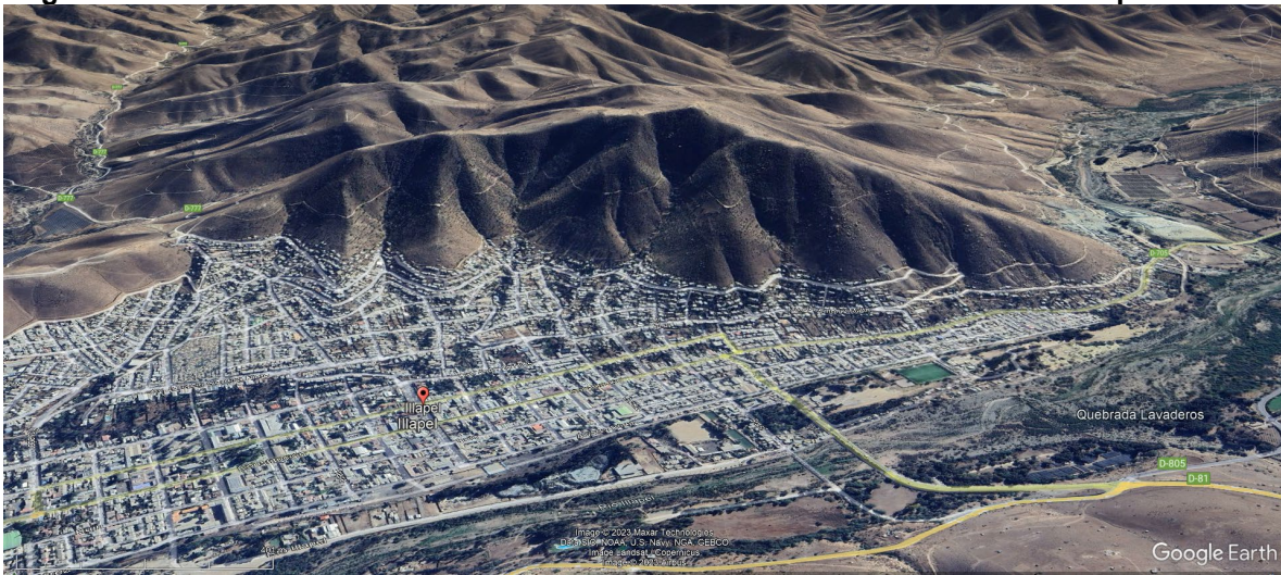
Figura 34- Elevación del área afecta a remociones en masa en los taludes de Illapel urbano.
