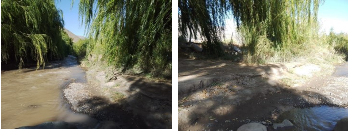
Foto 7 y Foto 8: Diferencia de altura entre lecho inundable del río y la T 1 que va contigua a la vía pública en Chillepín.
