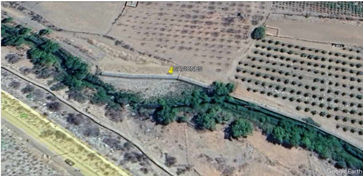
Figura 56- Presencia de gaviones en las orillas del Río Choapa a la altura de Chillepín, frente a la ruta D-825.
