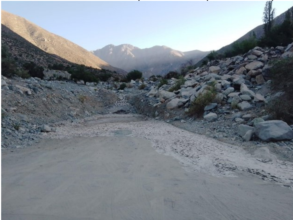
Foto 4- tomada desde la Ruta D-825 pasando sobre la quebrada de Tranquilla.
