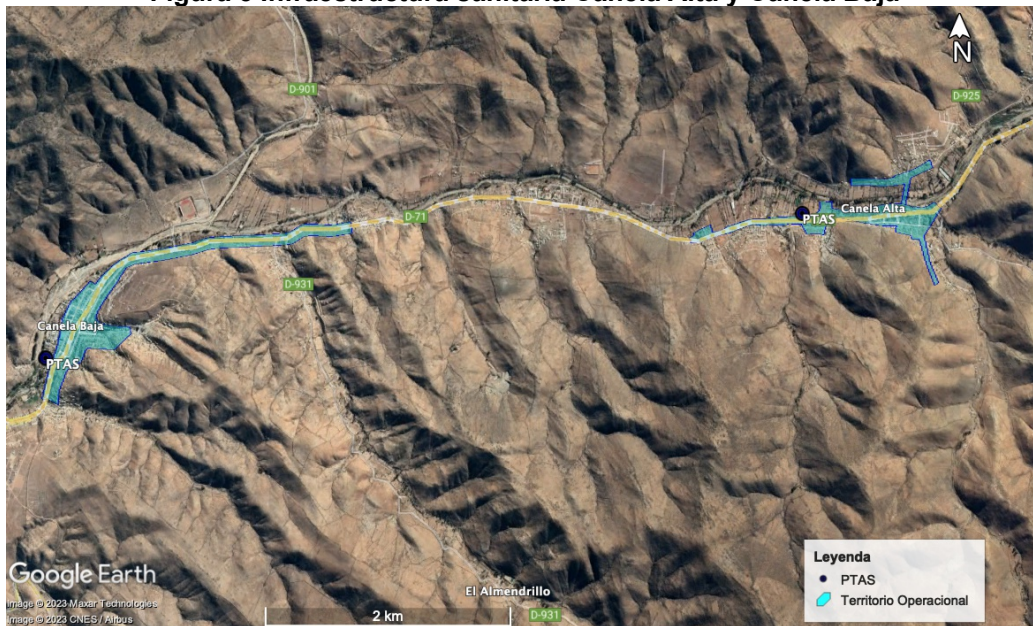
Figura 5 Infraestructura sanitaria Canela Alta y Canela Baja
