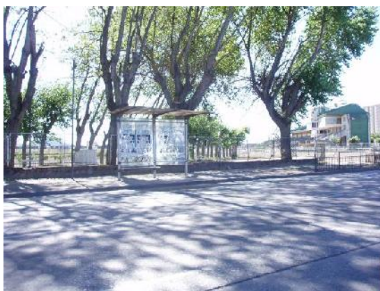
Vista exterior del actual Club Hípico reconstruido en 1992 después de un incendio ocurrido el 28 de abril de 1990
