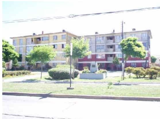
Edificios Villa Pdte. Bulnes por Colón
