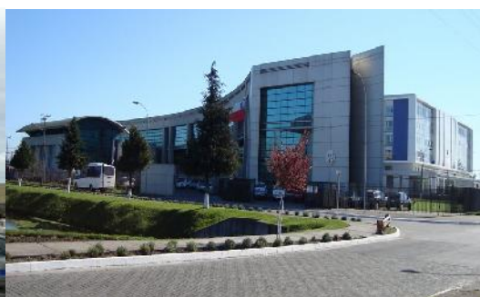
Edificio diario El Sur (Hoy Clínica Universitaria)
