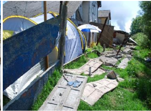
Daños en viviendas, muros de deslinde, etc.
