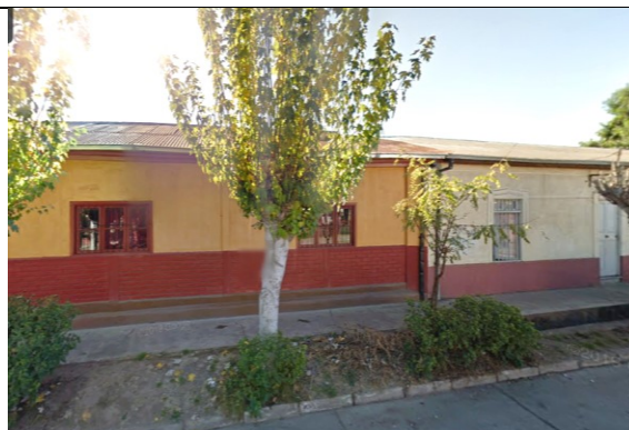
10.-Edificaciones calle C. Villouta.
