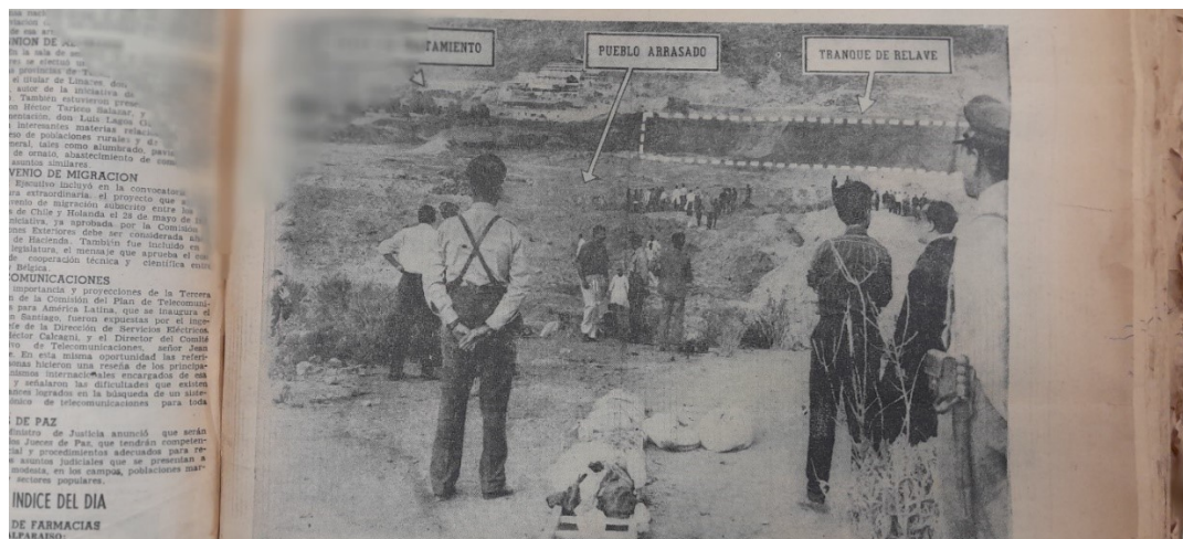
Fotografía 31. Vista Frente del Aluvión en Mina El Soldado, 1965
