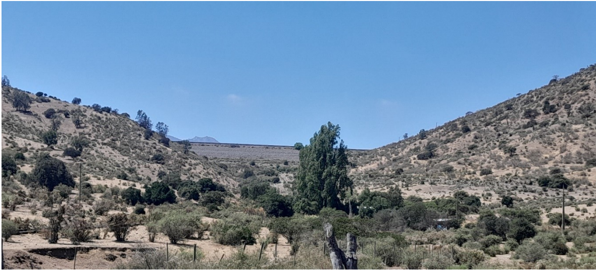
Fotografía 3. Vista del Muro de Contención del Tranque de Relave N° 4 de la Mina El Soldado
