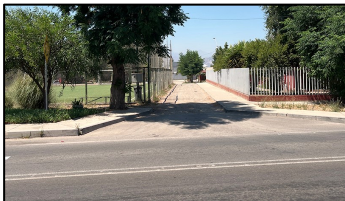
Figura 68. Situación pasaje lateral Avda. José Cortés – sin pavimentar
