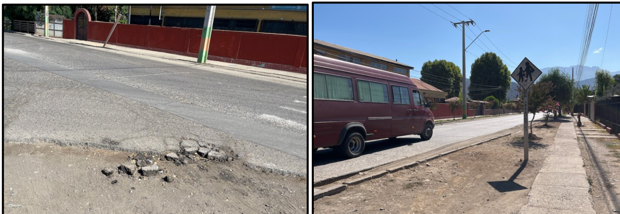
Figura 51. Cruce peatonal Liceo Felipe Cortés
