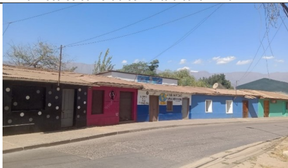
5.-Edificaciones frente a calle A. Prat.
