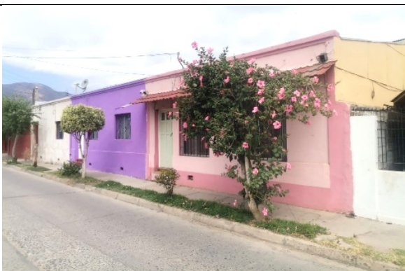
9.-Edificaciones calle Velázquez.
