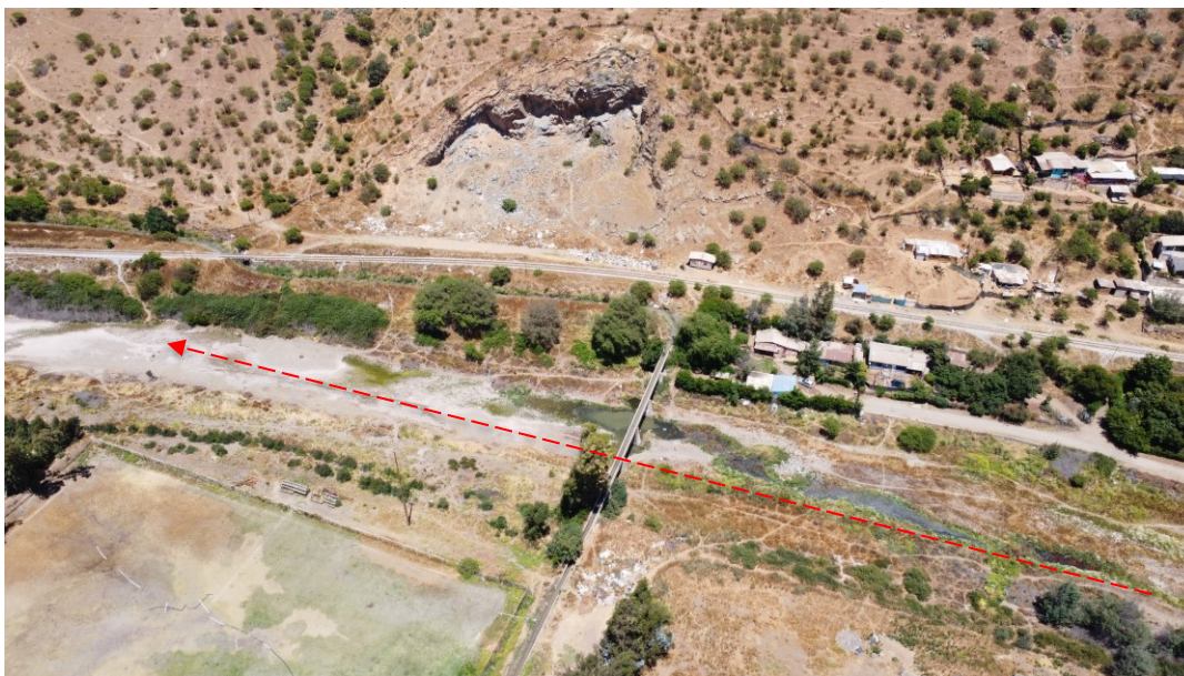
Fotografía 17. Estero El Melón al poniente de la Planta de Tratamiento de Aguas Servidas
