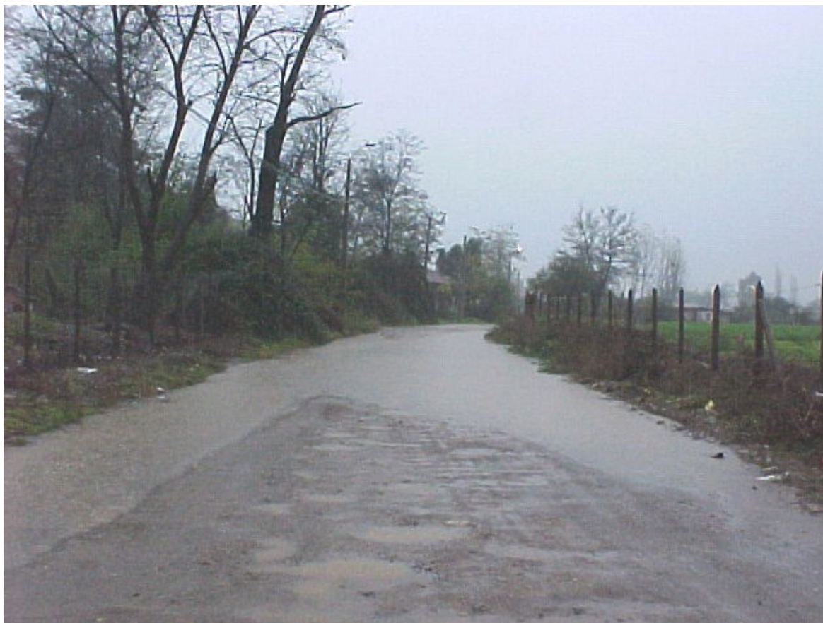
Fotografía 11. Camino Huella canal en acceso a Población El Polígono
