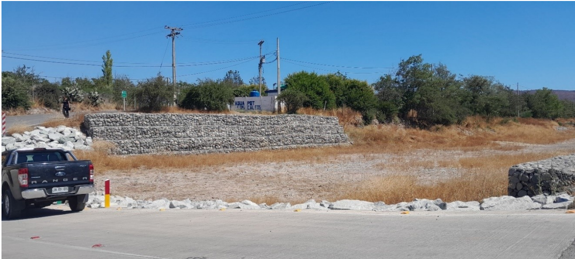
Fotografía 18. Obras de Conservación en el Estero El Cobre Sector APR Los Caleos
