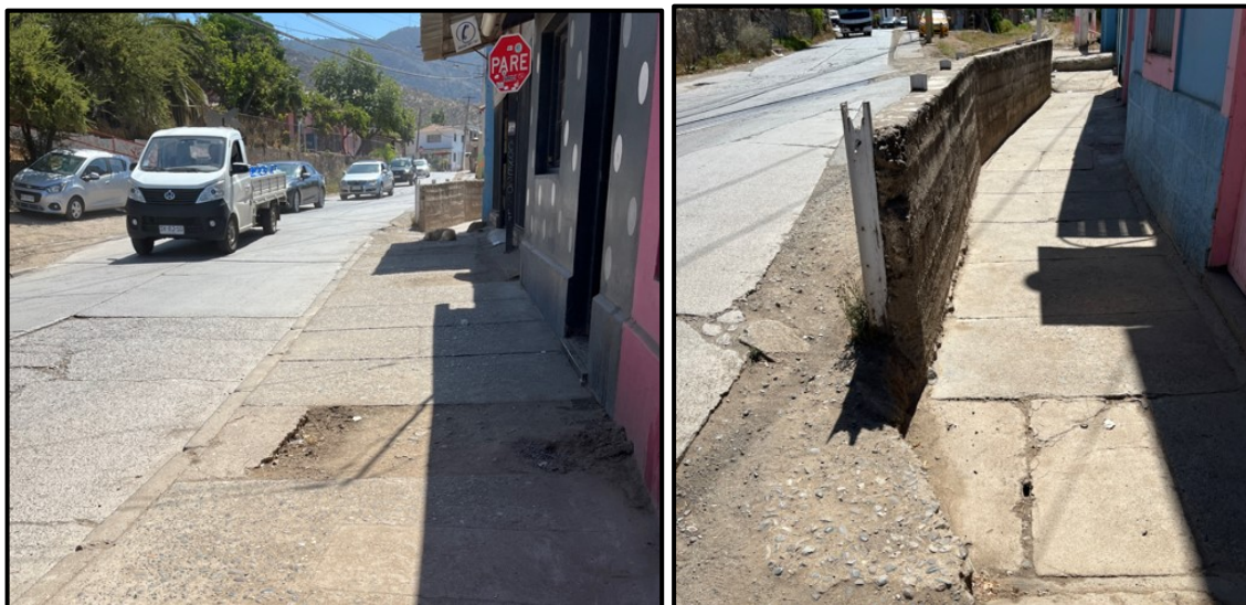
Figura 18. Situación veredas en desnivel – Avenida Isabel Brown
