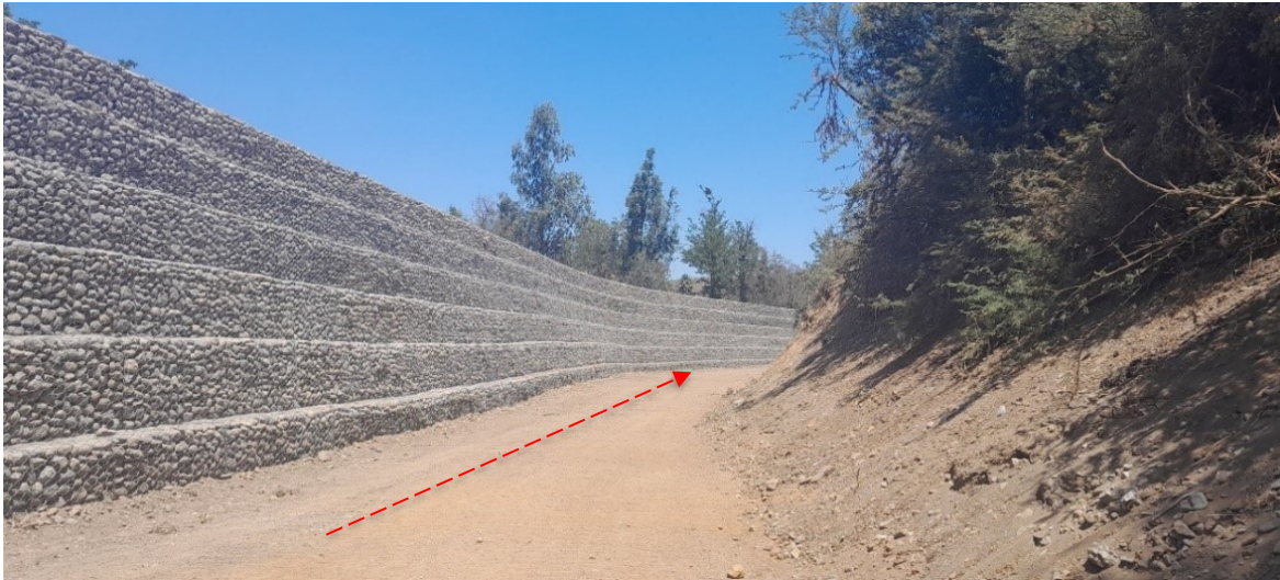
Fotografía 12. Obras de Conservación con Gaviones en el Estero Pucalán
