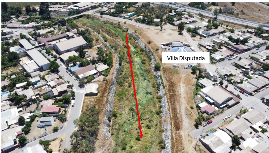
Fotografía 21. Obras de Conservación con Gaviones en el Estero El Melón, Villa La Disputada
