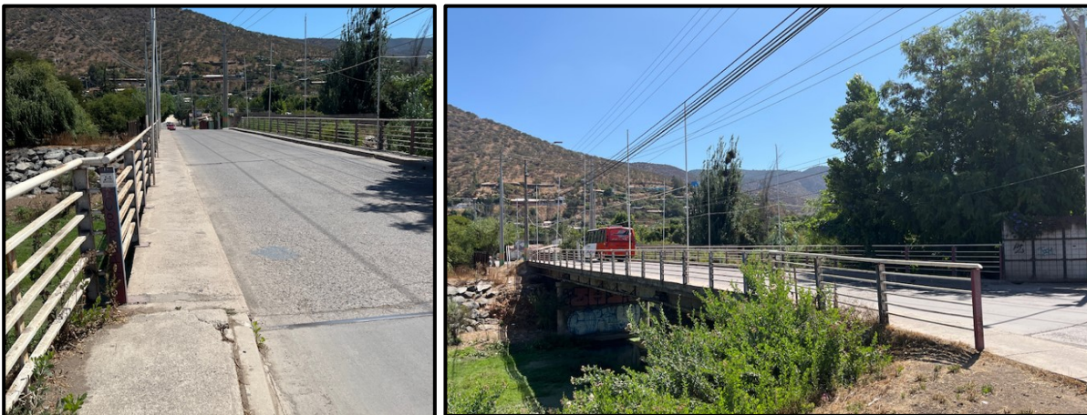
Figura 28. Puente sobre Estero El Melón
