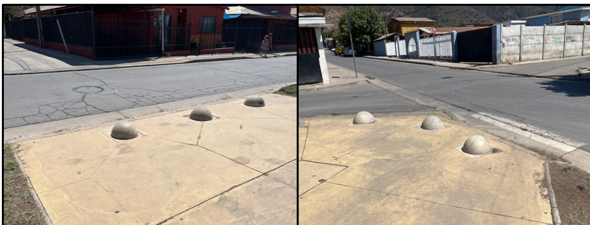
Figura 42. Situación esquinas Plaza de Armas sin Podotáctiles
