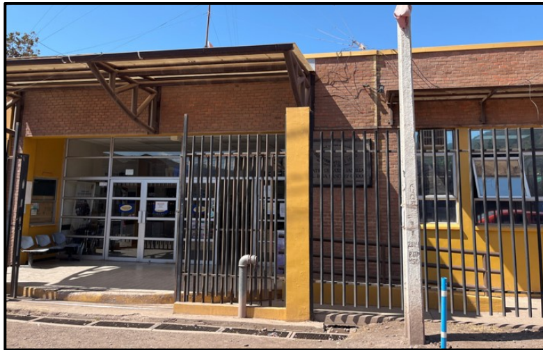
Figura 48. Situación acceso frontis CESFAM de El Melón
