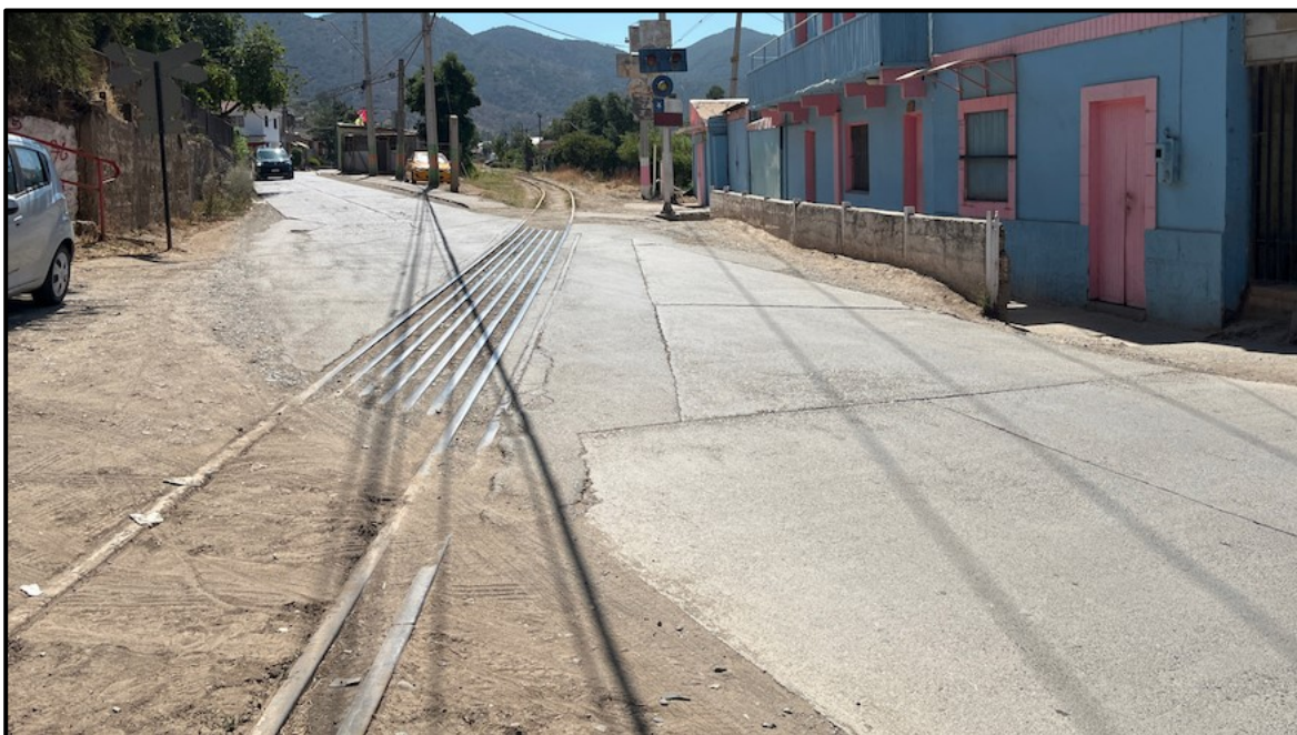
Figura 23. Vereda sin pavimentación – calle Isabel Brown, cruce línea férrea
