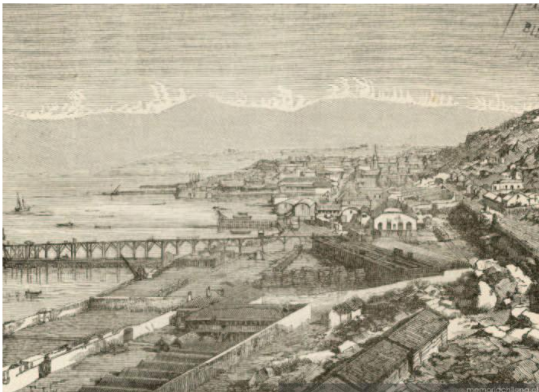
Figura 2-36. Lámina "Vista General del Puerto de Coquimbo". Fuente: Recadero Santos Tornero en Biblioteca Nacional.
