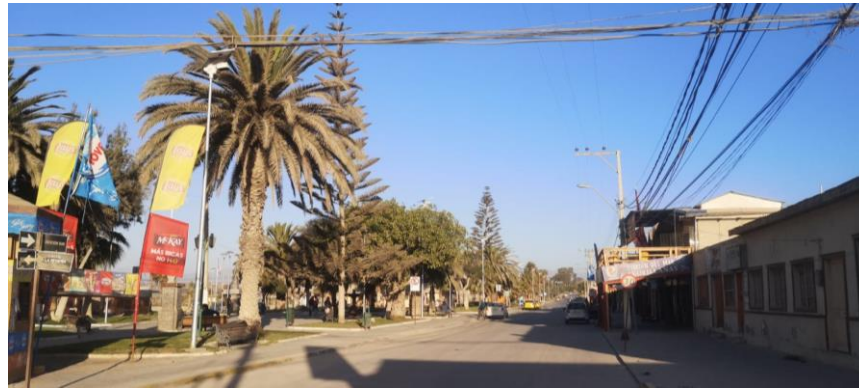
Figura 2-62. Vía Fundición en Tongoy. Fuente: Elaboración propia.
