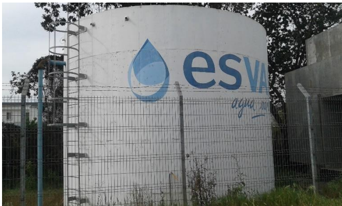
Estanque Captación de Agua ESVAL
