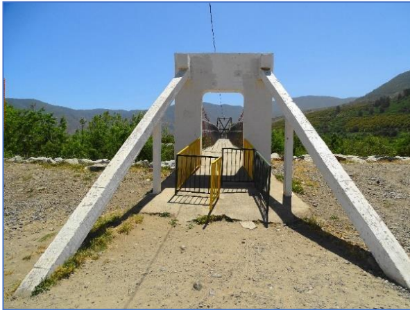
Figura 2-54 Fotografía Puente Lo Rojas
