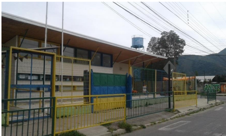
Figura 2-24 Infraestructura Sanitaria APR Foto Vista APR Sector Bolonia
