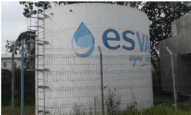
Estanque Captación de Agua ESVAL
