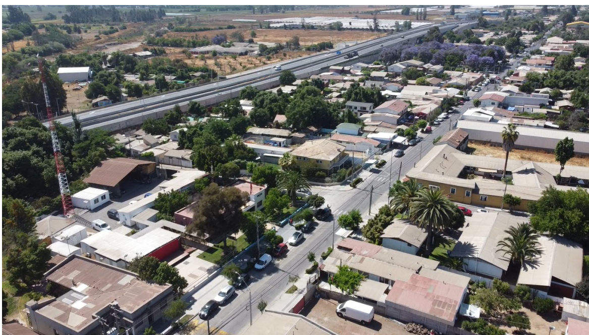
Fig. 18. Vista aérea del sector centro de Nogales con su trama fundacional.
