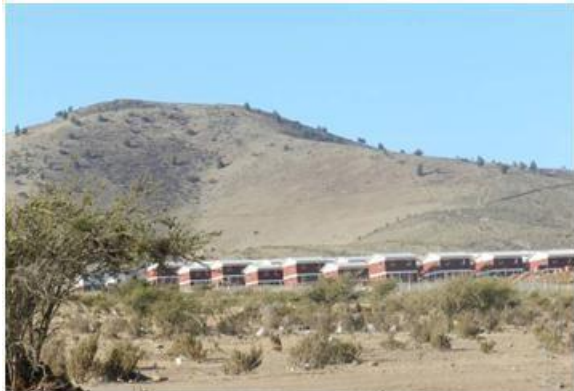
Foto 24: Villas en construcción sector Cuz Cuz
