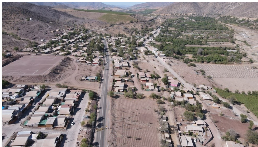
Fig. 34. Vista aérea Localidad de Huatulame
