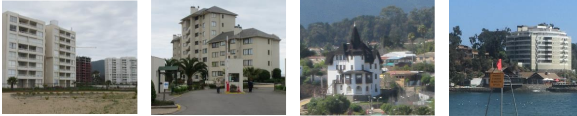
Ilustración 2.3-4 Caracterización de edificaciones Rango de Altura 6 a 8 pisos
