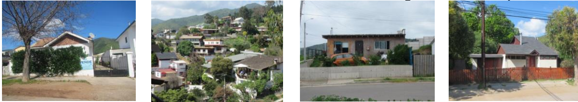
Ilustración 2.3-2 Caracterización de edificaciones Rango de Altura 1 a 2 pisos
