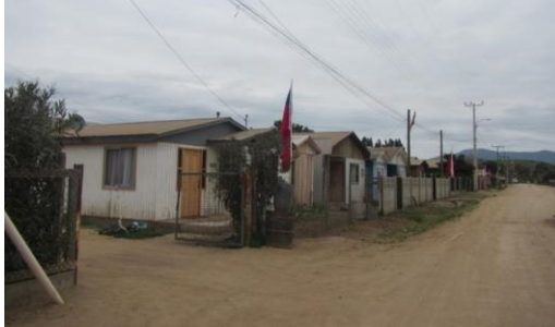
Situación fachadas (3 oriente)
