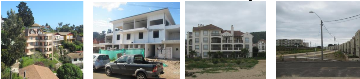
Ilustración 2.3-3 Caracterización de edificaciones Rango de Altura 3 a 5 Pisos
