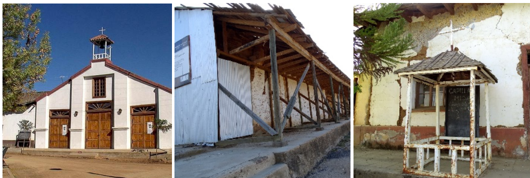
Figura 4-22. Monumento Parroquia San Luis Gonzaga de Sauzal antes del terremoto y en la actualidad
