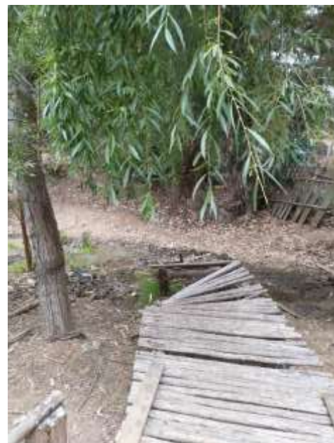
Puente construido bajo sauce y sobre vertiente que nace y termina al interior de la misma Quebrada de La Cruz. Dicho sector corresponde a terrenos de futuro Liceo, y bien podría construirse un sendero inclusivo, implementando un Plan de Infraestructura Verde de Pichilemu. Este puente fue construido por personas que transitan habitualmente por el lugar.
