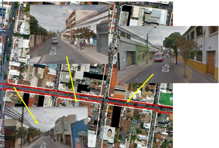
Calzada vehicular con 2 pistas y 6 metros en total
