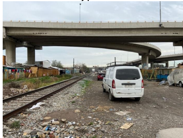
Ilustración 23 Línea del FFCC y paso sobre nivel a Camino Melipilla.
