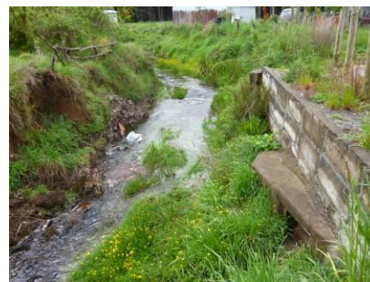
Figura N° 20. Sistema de evacuación de aguas lluvias mal orientado.
