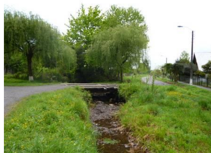
Figura N°30. Puente en Pasarela en área de inundación localidad de Choroico.
