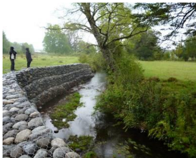
Figura N° 4. Gaviones en Estero Cunco.
