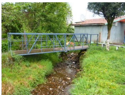
Figura N° 29. Pasarela en área de inundación localidad de Choroico.
