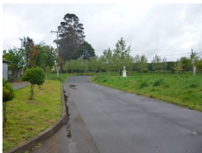
Figura N° 18. Vista oriente-Poniente de calle Anguita que sufre inundaciones.
