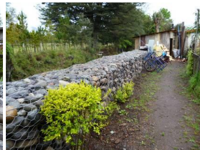
Figura N° 6. Gaviones minimizando proceso de Remoción de la Ladera del Estero Cunco.
