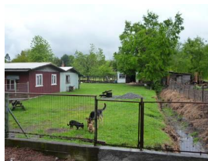
Figura N°34. Viviendas y predio afectados por desbordes del canal.
