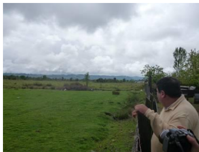
Figura N° 16. Vista poniente-oriental de área definida como de anegamiento.
