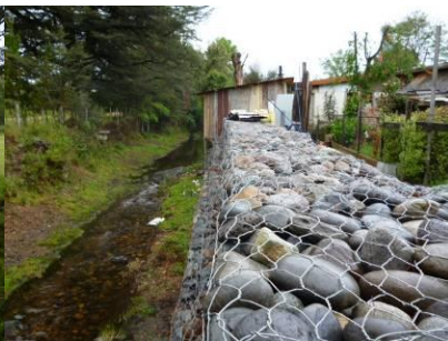
Figura N° 5. Gaviones minimizando proceso de Remoción de la Ladera del Estero Cunco.
