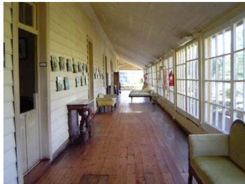
La galería conecta diferentes espacios interiores
