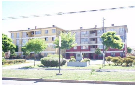
Edificios Villa Pdte. Bulnes por Colon
