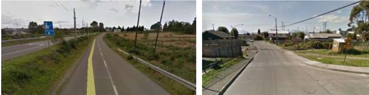
Figura 99 Acceso a Pto Varas y cruce de vía ferre en la ciudad
