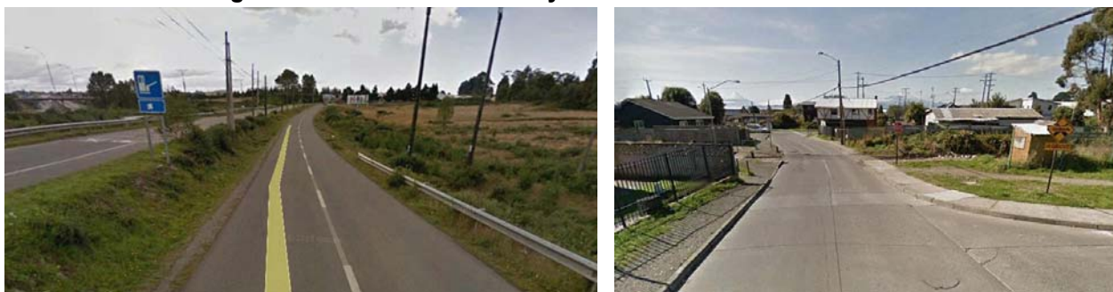
Figura 80 Acceso a Pto Varas y cruce de vía ferre en la ciudad
