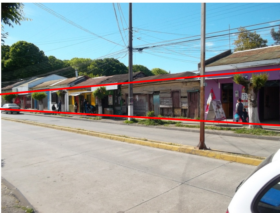
Calle Comercio entre Santiago Watt y Progreso, tipología de construcciones que dominan la zona a conservar.
