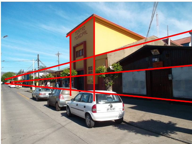
Teatro Municipal de Renaico, Comercio c/n Progreso, diferentes alturas predominantes en la zona, Hito arquitectónico y cultural de Renaico, se busca que estos edificios mantengan este carácter y no compitan, que sean fácilmente reconocibles.
