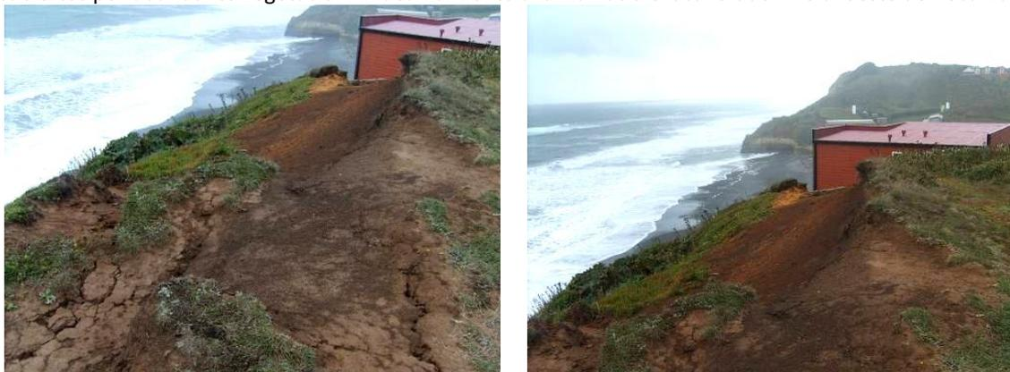
**Imagen N°66:** Viviendas afectadas directa e indirectamente por sistema de grietas y movimiento rotacional.
