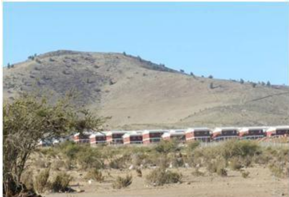
Foto 24: Villas en construcción sector Cuz Cuz
