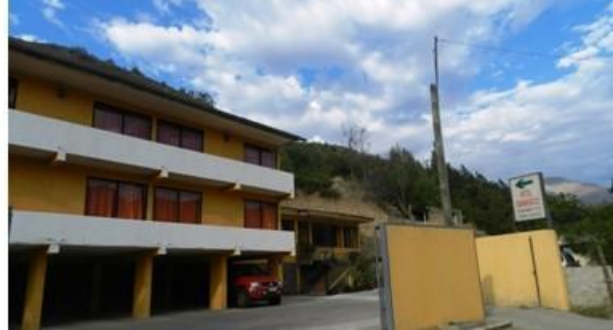
Foto 29: Hotel en sector Chillepín
