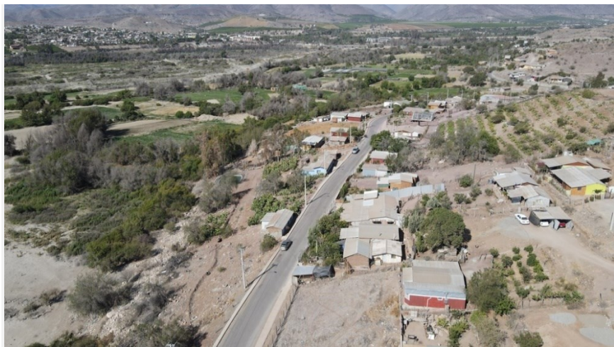
Fig. 27. Vista aérea Localidad de Huana Fuente: Archivo fotográfico Consultor, 2022
